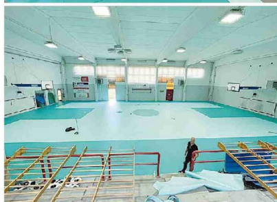
In alto i lavori di posa; sotto la pavimentazione completata
