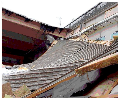
Crollata ieri mattina sotto il peso della neve una porzione del tetto del nuovo palasport inaugurato a fine 2008. Si è rischiata la tragedia: poche ore dopo l'edificio si sarebbe riempito di bambini per le consuete attività sportive.
